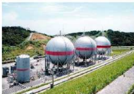
図 21: 液化水素貯蔵タンク(真空二重殻断熱構造)
